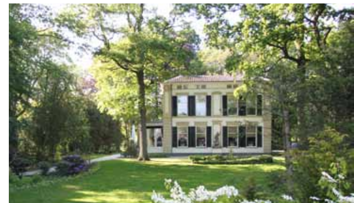
De zuidgevel in 2015.
