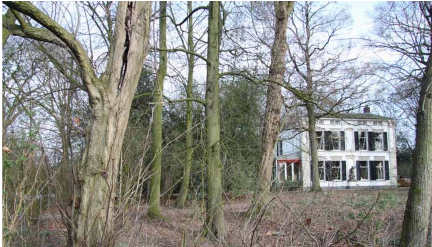
De zuidgevel van Rijnoord. (situatie februari 2014)
