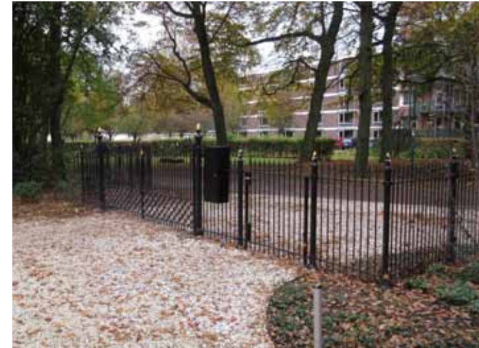
De gerestaureerde poort, hier vanaf het terrein gezien.
