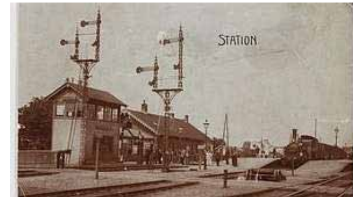
Het eerste station van Woerden. Bron: Regionaal Historisch Centrum Rijnstreek en Lopikerwaard
